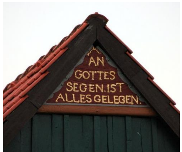
A German Roof Peak An Gottes Segen Ist Alles Gelegen ("On God's Blessing Everything Depends")
